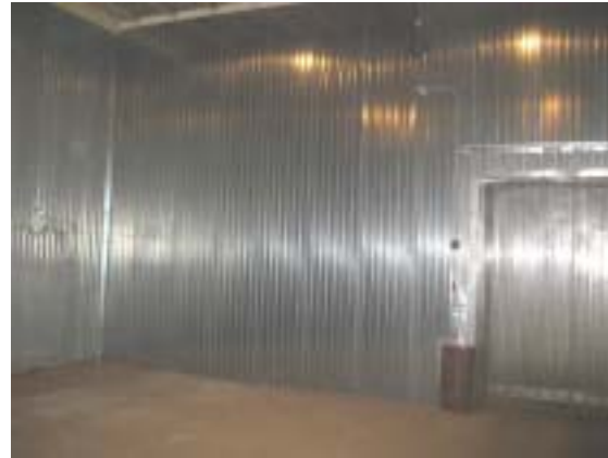
C級～F1級可変冷凍庫 3号館 2階前室
