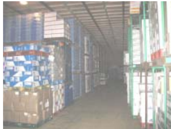
F1級冷凍庫 3号館2階
